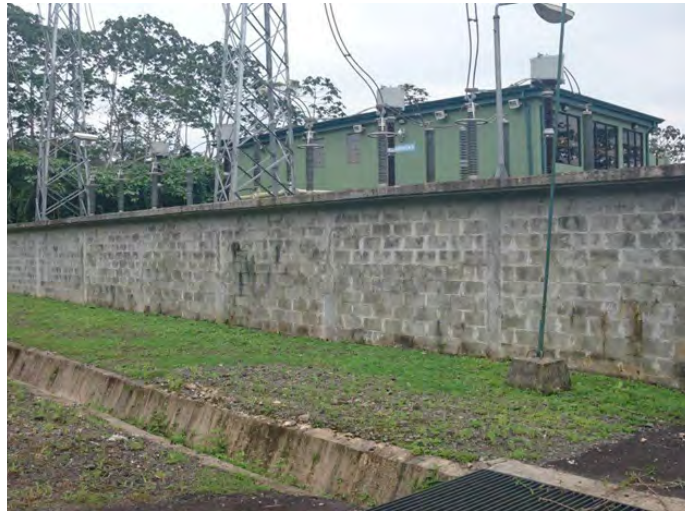
Figura 25. Barrera perimetral ideal para centro de interruptores y subestaciones (Fuente: CNFL).
