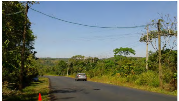
Figura 28. Pasos de fauna arborícola; diferentes diseños colocados y utilizados para el uso de la fauna arborícola (Fuente: ICE y CNFL).
