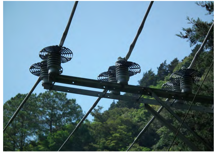
Figura 40. Cobertor de silicón tipo manguera, para aislar el cable (Fuente: CNFL).
