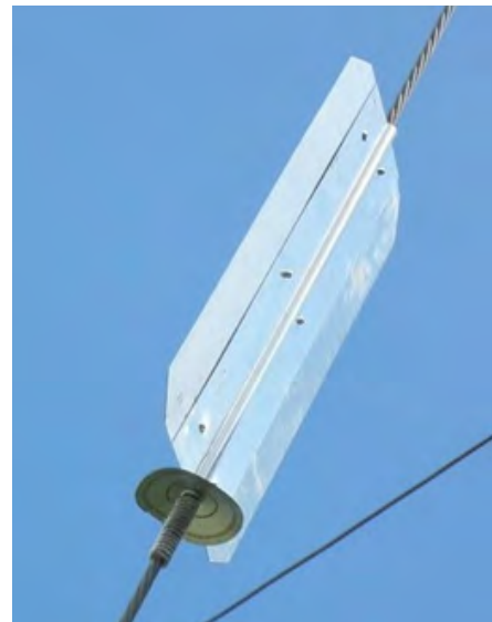
Figura 29. Dispositivo antiescalamiento tipo paleta de 20 X 50 cm, y su diseño. (Fuente: CNFL).
