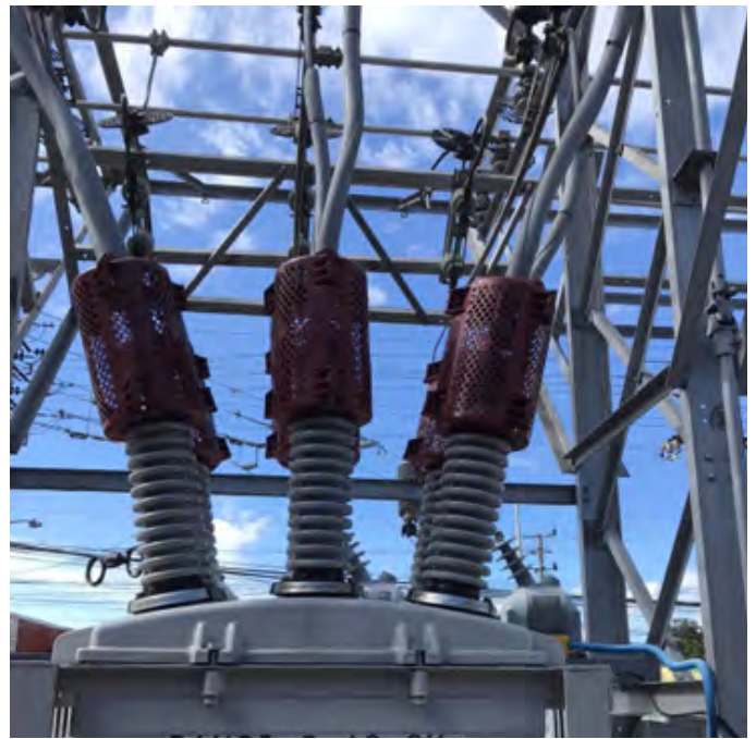
Figura 38. Izquierda: cobertor de polímero rígido para protección de terminal en transformador (Fuente: ESPH); y a la derecha cobtores de polímero rígido en aisladores de porcelana y cobtores de silicón para cables desnudos, colocados en interruptores de subestación (Fuente: CNFL).
