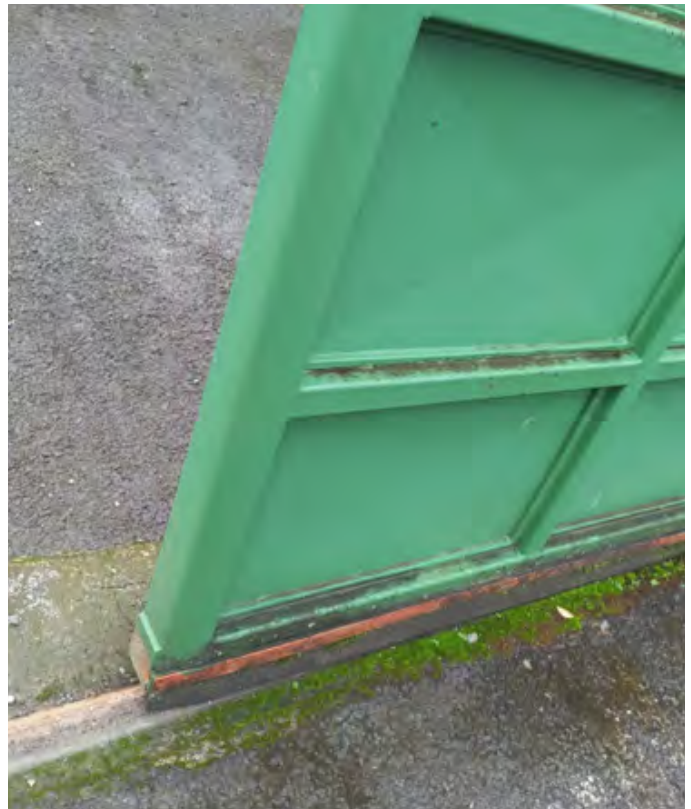
Figura 26. Diseño de portón corredizo con cierres de hule para reducir espacios o aperturas (Fuente: CNFL).
