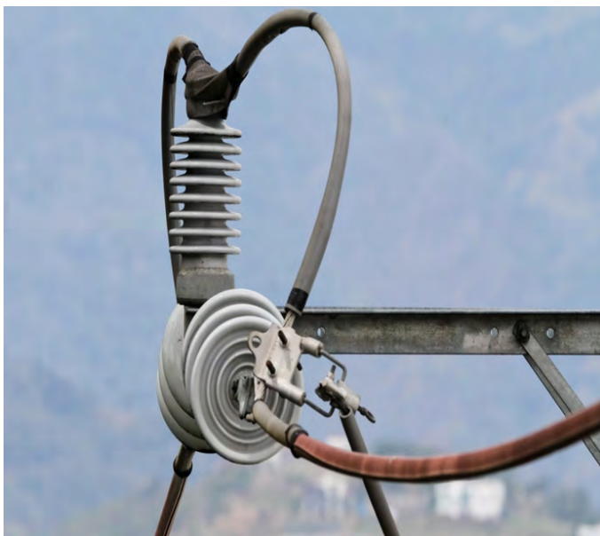
Figura 39. Cobertor de silicón tipo manguera para aislar el Jumper y cobertor de polímero rígido para el cable eléctrico (Fuente: ESPH).
