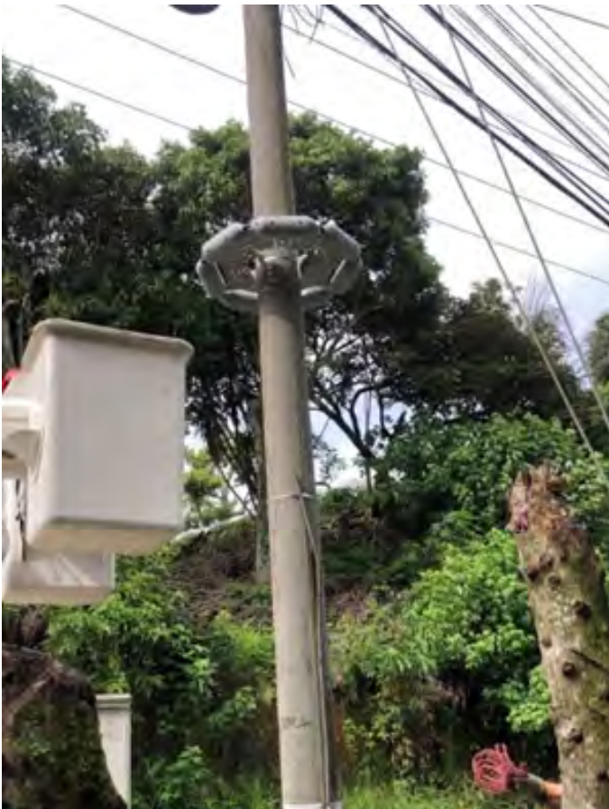
Figura 35. Dispositivos barrera para evitar que fauna trepe por el poste del tendido eléctrico. (imágenes fuente ESPH).
