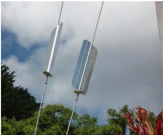
Figura 29. Dispositivo antiescalamiento tipo paleta de 20 X 50 cm, y su diseño. (Fuente: CNFL).
