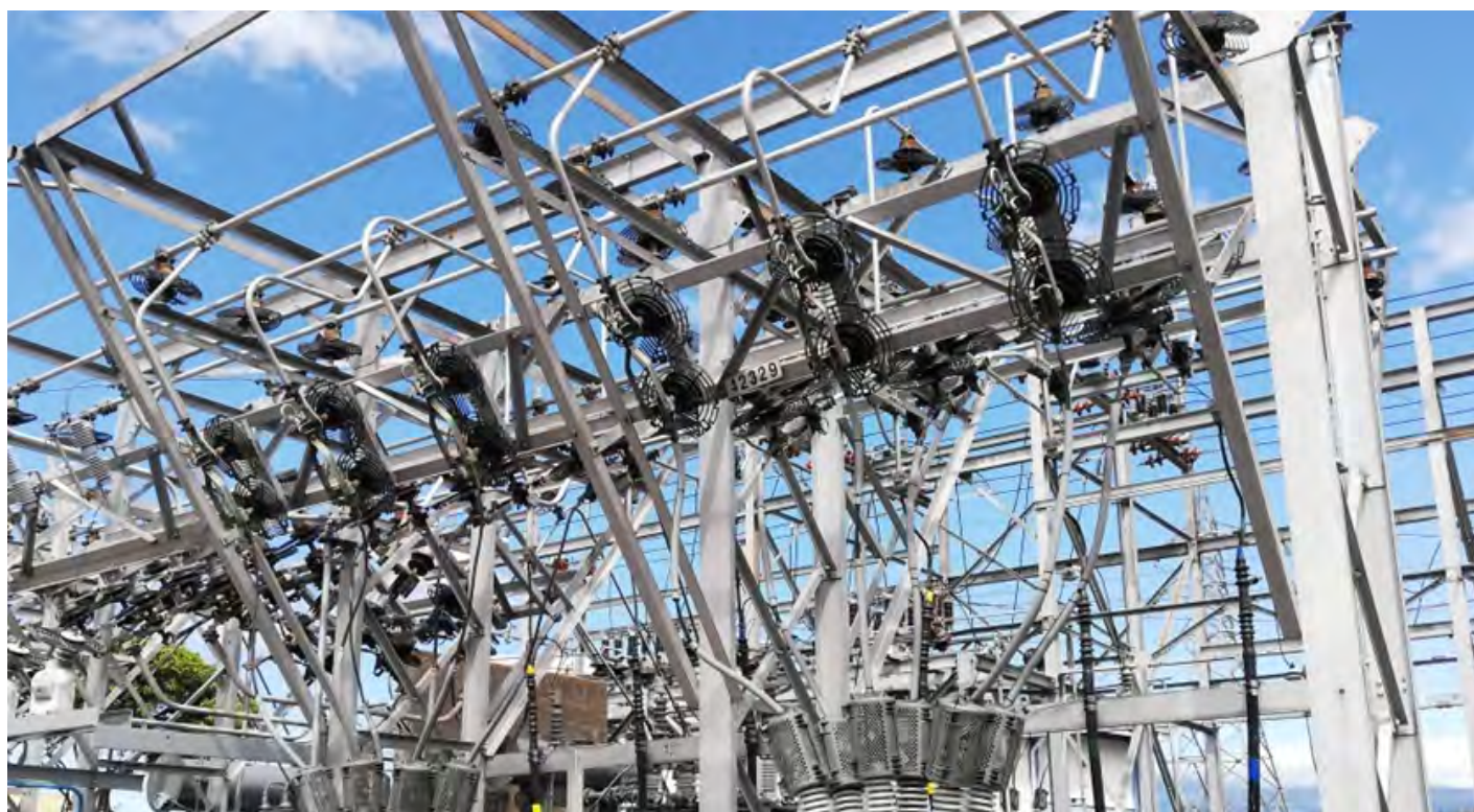
Figura 43. Subestación protegida con protectores electrostáticos, cobertores de polímero rígidos y cobertores de silicón tipo manguera para cables. (Fuente: CNFL).
