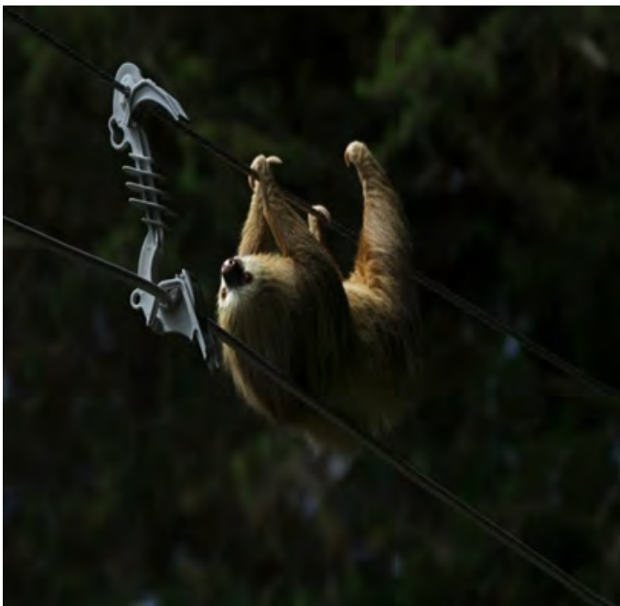
Figura 44. Ejemplos de Cable conductor con recubierta semiaislada (Fuente: CNFL y ESPH).
