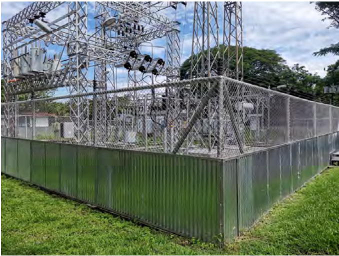
Figura 25. Barrera perimetral ideal para centro de interruptores y subestaciones (Fuente: CNFL).
