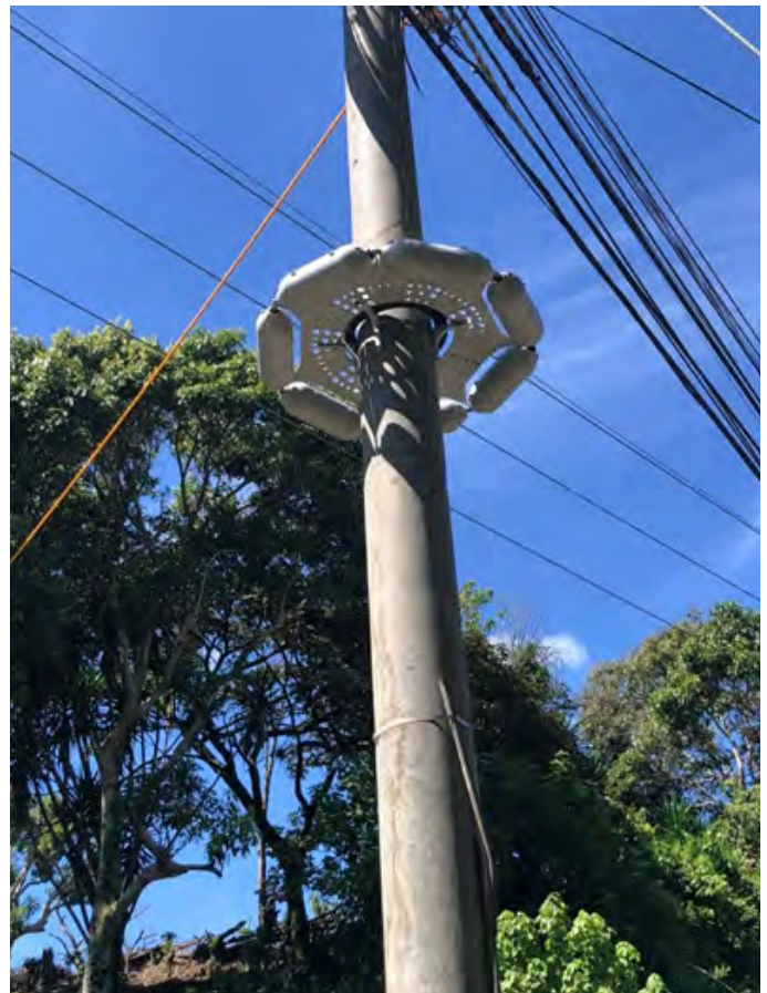
Figura 35. Dispositivos barrera para evitar que fauna trepe por el poste del tendido eléctrico. (imágenes fuente ESPH).
