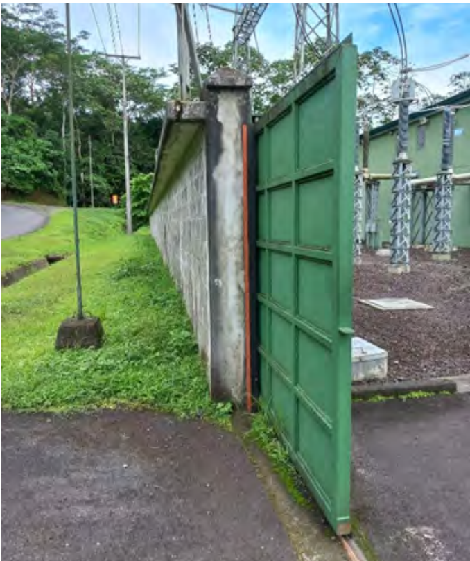
Figura 26. Diseño de portón corredizo con cierres de hule para reducir espacios o aperturas (Fuente: CNFL).
